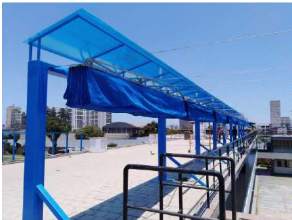
Sistema de toldos plegadizos con motores
