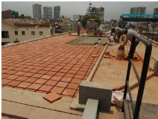
Cobertura con pastelero
