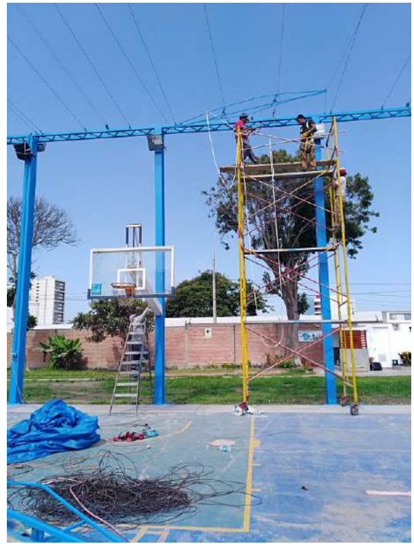
Trabajos en altura
