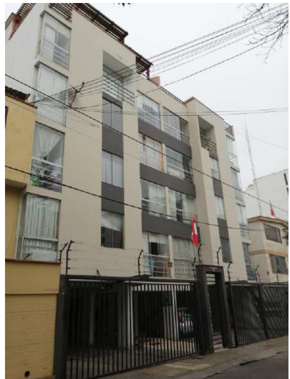
Edificio Rodolfo – Surquillo
