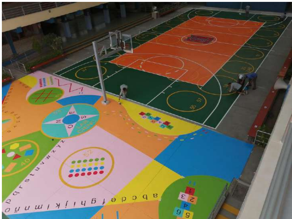
Pintado de pisos con pintura epóxica
