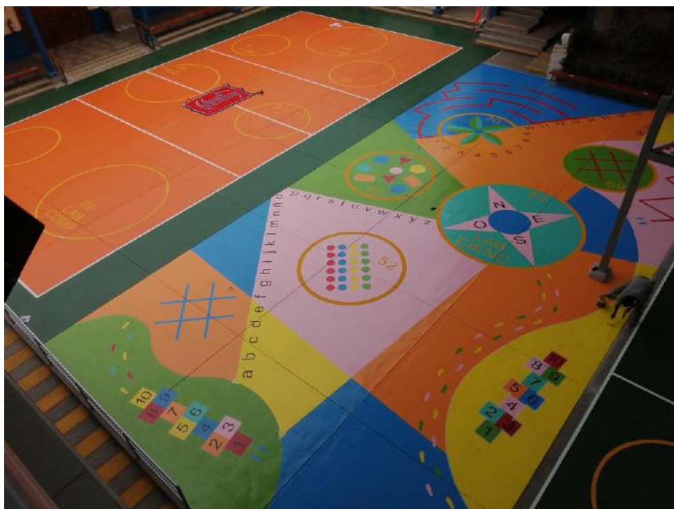
Pintado de pisos con pintura epóxica
