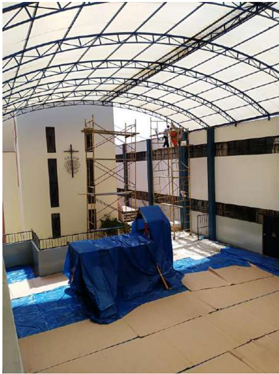
Mantenimiento estructuras metálicas
